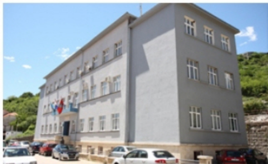
Sl. 4. Zgrada Veleučilišta "Marko Marulić"
