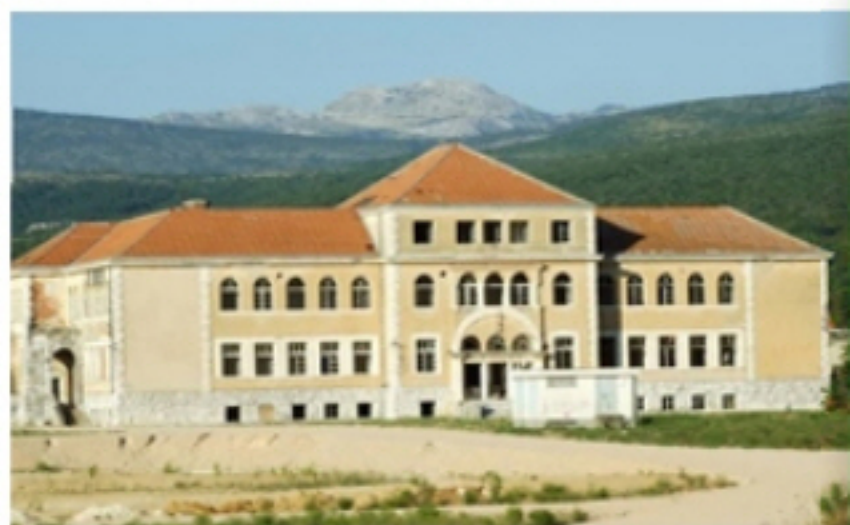
Sl. 10. Zgrada bivše učiteljske škole u pod. zoni "Preparandija"
